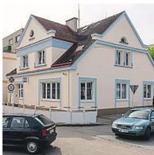
Po opravě Nová služebna policie ve Smiřicích. 2x foto: ČTK
